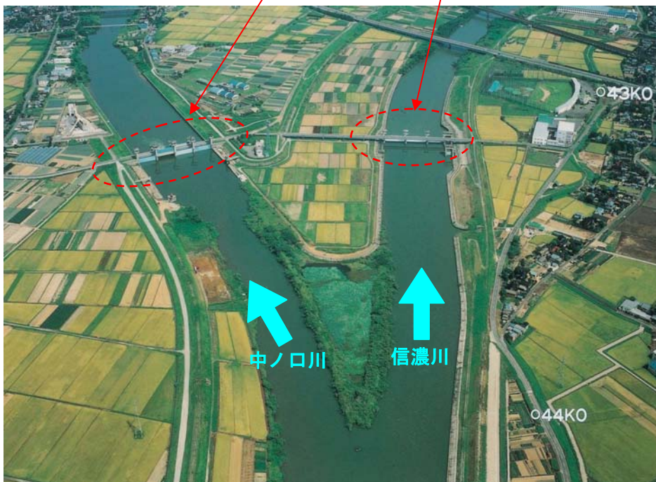
現在の中ノ口川分派点（蒲原大堰・中ノ口川水門）
