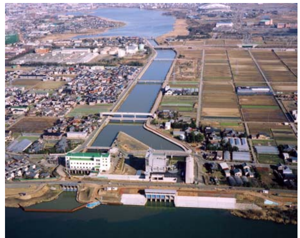
鳥屋野潟排水機場
