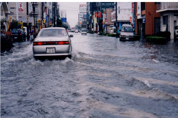
幹線道路の浸水状況（新潟市笹出線）
