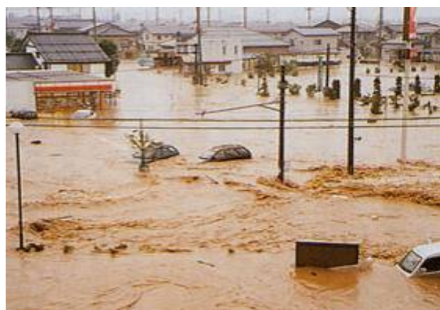
刈谷田川の破堤状況(旧中之島町)
