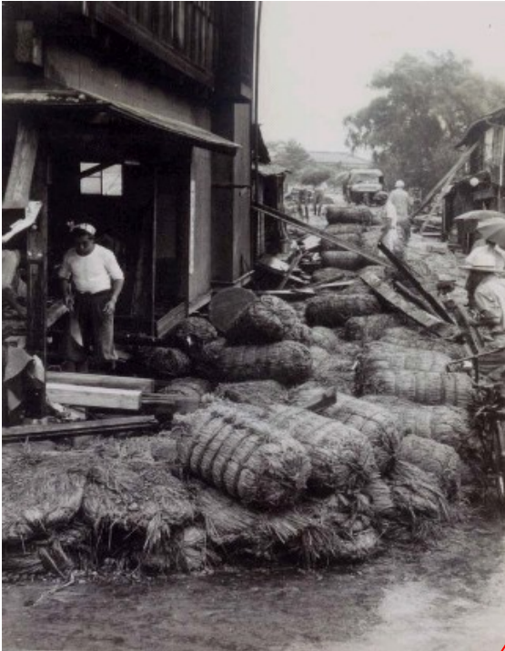
S36 年洪水時の米俵による水防状況 (中ノ口川)
