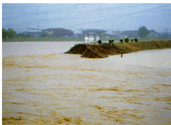
五十嵐川の破堤状況
