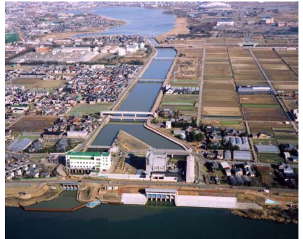
鳥屋野潟排水機場
