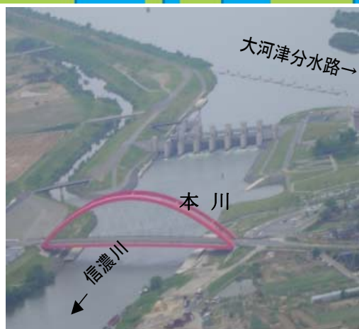
信濃川下流直轄管理区間上流端の本川橋
