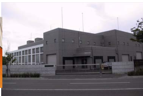
小新ポンプ場
